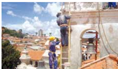
Refacción de espadaña de la Iglesia de San Lázaro
